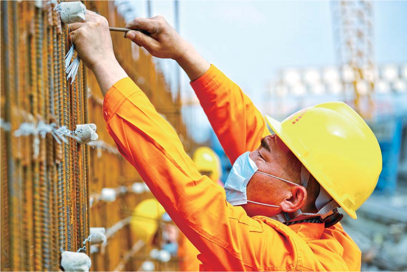
▲ 4 月 10 日,在中铁四局西南环线白云制梁场,工作人员绑扎钢筋。目前,贵阳市域快铁西南环线工程建设有序推进。
