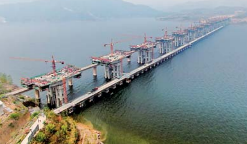
渑垣黄河特大桥加紧建设
