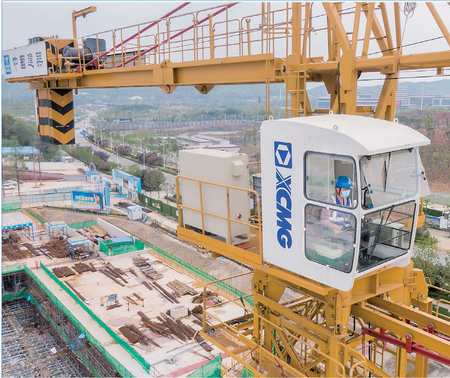
▲ 3 月 26 日，塔吊工张吉明在湖北广电传媒基地工程长江文创产业园项目工地操作塔吊机（无人机照片）。 湖北广电传媒基地工程 3 月 25 日正式复工，目前已有 400 余名管理人员和劳务工人顺利重返工地，未来一周还将有超过 500 名工人分批返岗。该工程是我国中部地区首个国家级广播影视媒体基地。3 月 25 日，经过严格审核，工程复工申请获得武汉市东湖高新区疫情防控指挥部批复。 新华社记者程敏摄
