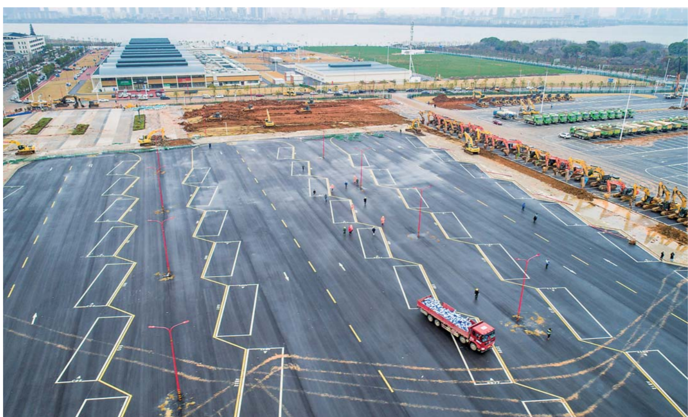
▲1月26日，在武汉雷神山医院建设工地，大型机械加紧施工（无人机照片）。1月25日下午，武汉市新型冠状病毒感染的肺炎疫情防控指挥部召开调度会，决定除武汉蔡甸火神山医院之外，半个月之内再建一所应急医院——武汉雷神山医院。雷神山医院选址武汉市江夏区黄家湖，初定新增床位1500张，分为两栋建筑，建筑面积约3万平方米，可容纳2000名医务人员工作。（新华社记者肖艺九摄）
