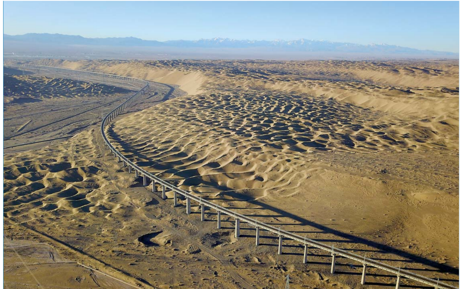
▲敦格铁路沙山沟特大桥(12月11日无人机拍摄)。敦(煌)格(尔木)铁路沙山沟特大桥位于甘肃省酒泉市阿克塞哈萨克族自治县境内的库姆塔格沙漠内，是一座穿越活动性沙漠地区的特长桥梁，也是敦格铁路的重难点控制工程。据介绍，桥梁所在区域风沙活动频繁，四季及昼夜温差大，在建设过程中，中铁十一局集团有限公司的建设者根据沙层的厚度、分布及含水率的不同，总结出一套沙丘桩基施工工艺。 新华社记者范培坤摄
