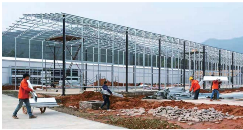
▲建设中的暂武蛋鸡场二期工程。 彭仁强摄
