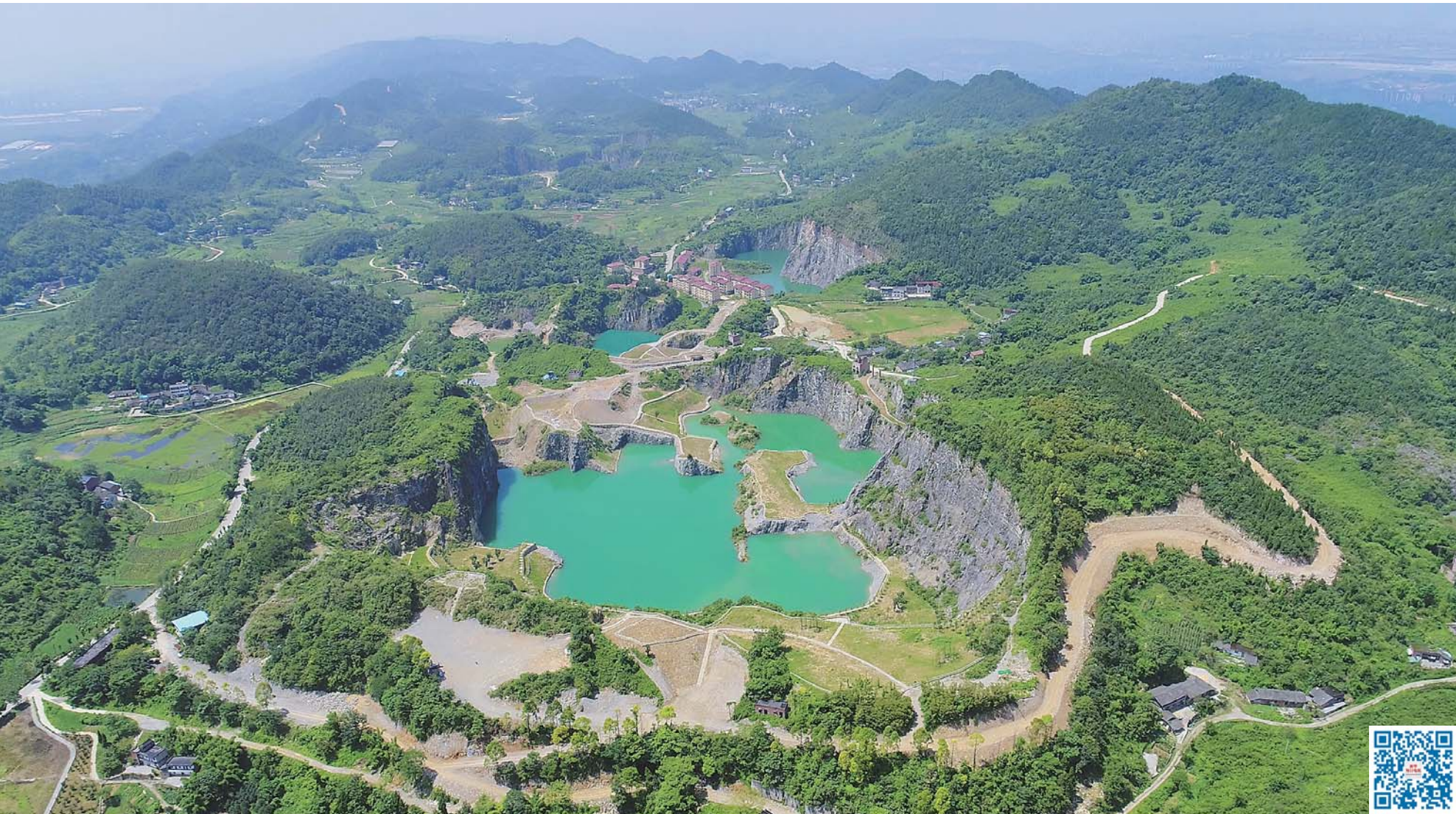
▲治理后的重庆市渝北区铜锣山废弃矿坑。
