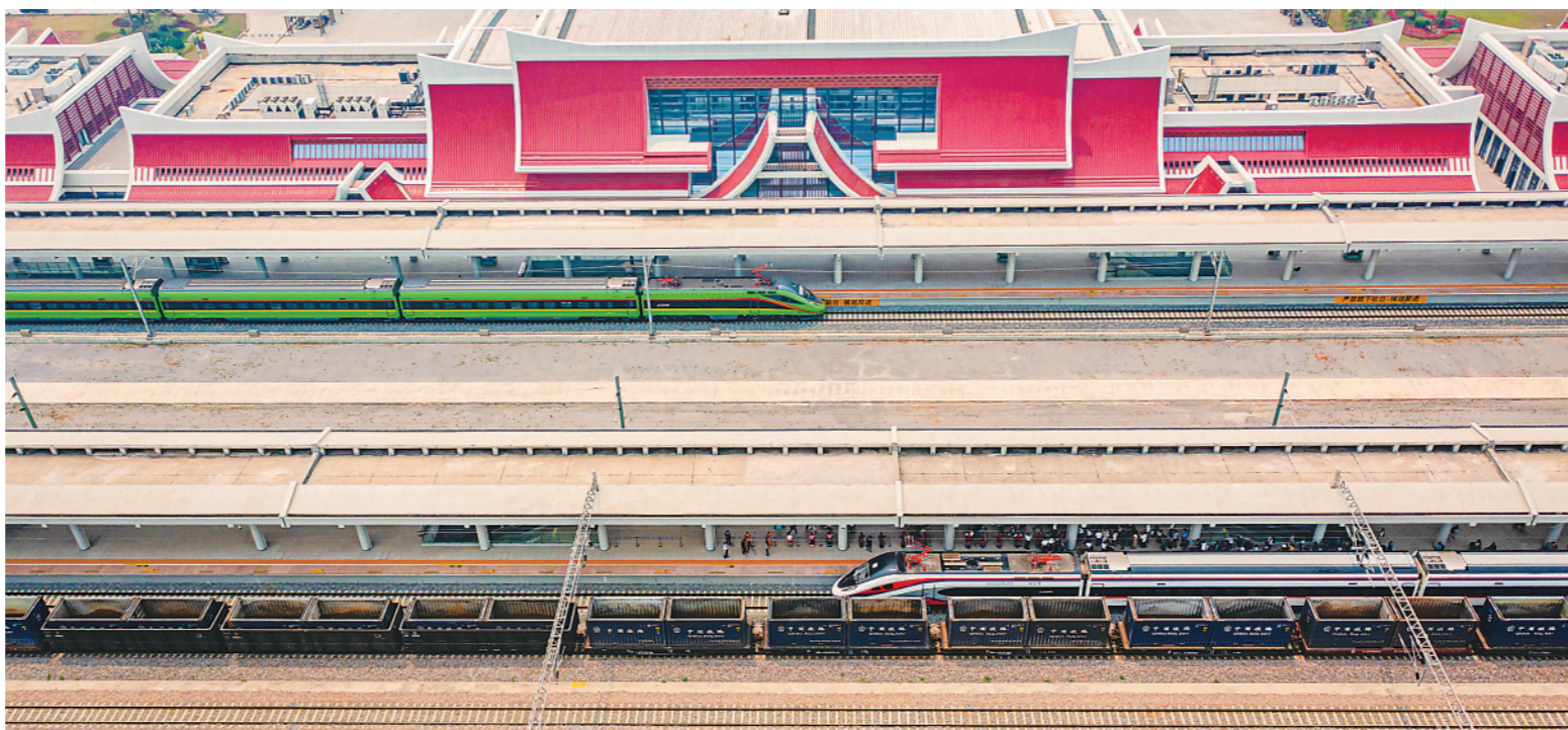
▲4月13日,“复兴号”(上)、“澜沧号”动车组列车停靠在中老铁路磨憨站。 新华社记者胡超摄
