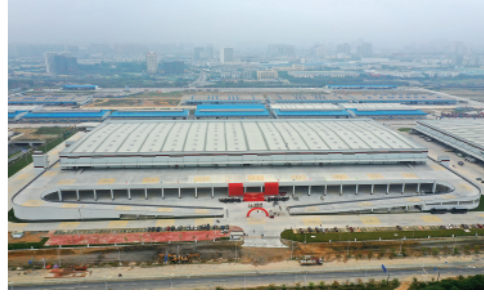
4月13日,广西面向东盟的大型现代化物流分拨中心——南宁国际铁路港顺丰分拨中心整体竣工并交付使用。新华社记者陆波岸摄
