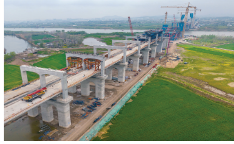
日前,连接安徽省巢湖市与马鞍山市的巢马城际铁路顺利完成全线首跨公路梁浇筑作业。 新华社发(汤德宏摄)
