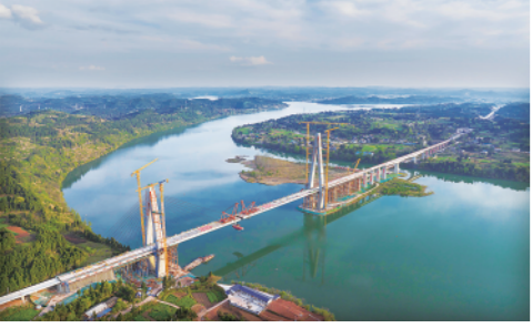
近日,由蜀道集团四川路桥承建、中铁五院设计的汉巴南铁路嘉陵江特大桥全桥顺利合龙。 新华社记者江宏景摄
