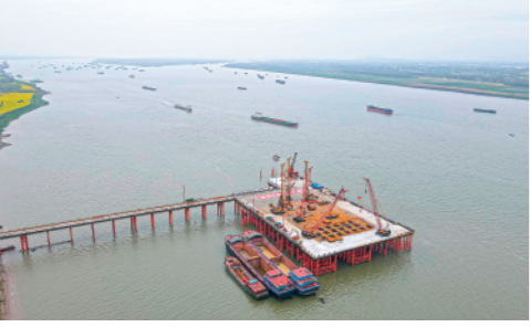
3月25日,由中铁大桥局承建的池州长江公铁大桥首个主墩顺利开钻。大桥主体工程全面开工。 新华社记者刘军喜摄
