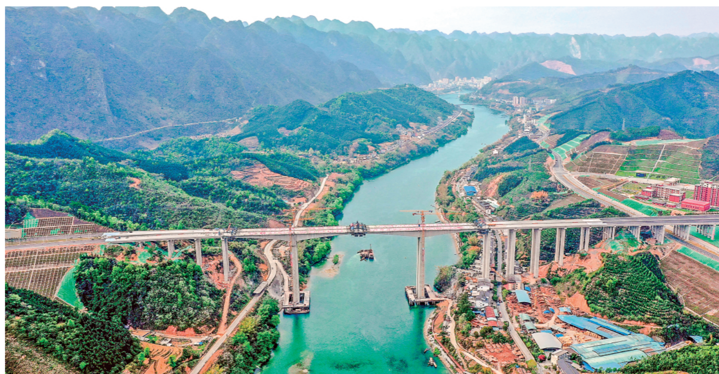
▲这是3月24日拍摄的天峨至巴马高速公路红水河特大桥。当日，由广西交通投资集团投资建设、中交二航局承建的广西最大跨径六车道连续刚构桥——天峨至巴马高速公路（简称天巴高速）红水河特大桥实现双幅合龙。红水河特大桥是天巴高速项目的控制性工程，位于广西河池市天峨县六排镇红水河上游，全长1099米。新华社发（高东风摄）
