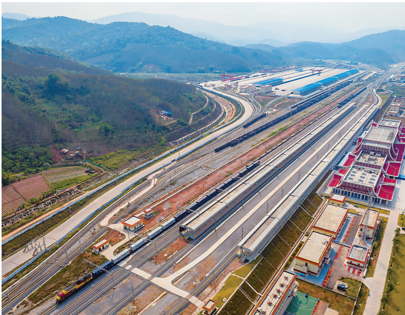
▲2月22日拍摄的中老铁路磨憨站。进入2023年，中老铁路国际联运货运量大幅提升，境内外运输需求旺盛。今年截至2月22日，中老铁路磨憨站已累计办理出境货车269列、9615车，货运量85760吨；入境货车363列、9288车，货运量522651吨，出境、入境货运量同比分别增长91%、496%。
