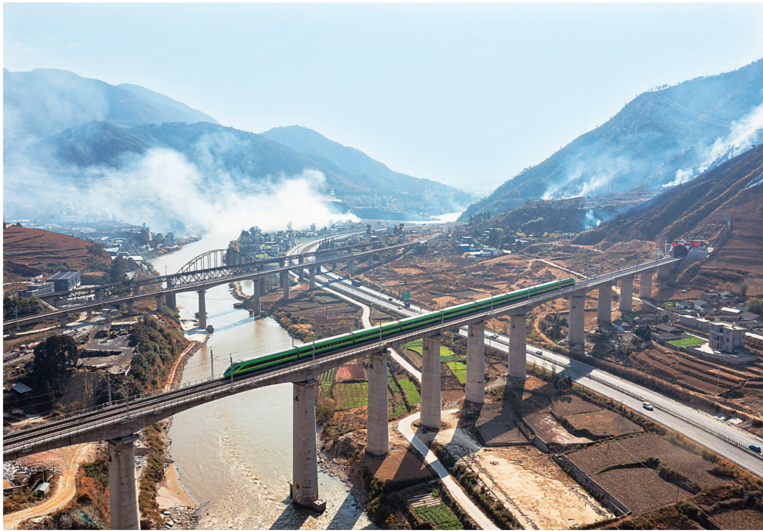
▲2022年12月26日,C45次列车行驶在新成昆铁路上。当日8时05分,C57次“绿巨人”复兴号动车组列车从成都火车南站缓缓启动,驶往西昌,这标志着新成昆铁路(成昆铁路扩能改造工程)的最后一段——峨眉至冕宁段开通投运,至此,全长915公里的新成昆铁路实现全线通车运营。
