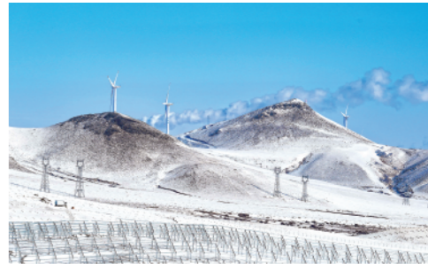
2月23日在内蒙古霍林郭勒市拍摄的霍林河循环经济示范工程风电光伏基地。新华社发(王正摄)
