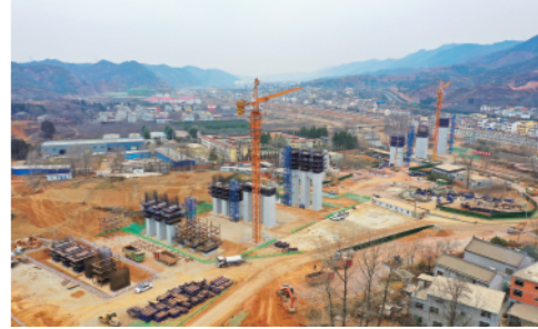
连日来,位于秦岭地区的西(安)十(堰)高铁陕西商洛段建设正酣(2月6日摄)。 新华社记者张博文摄
