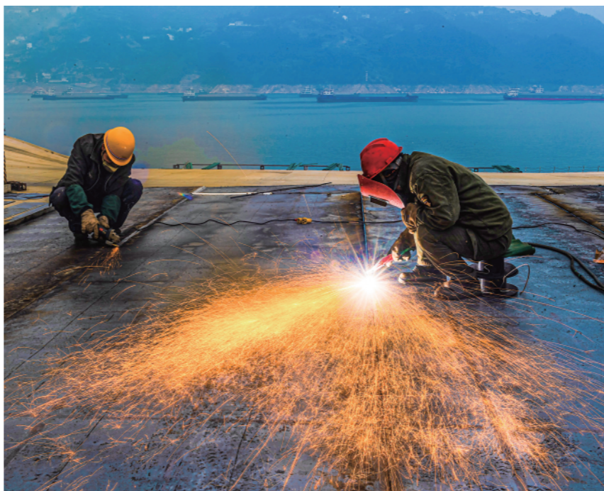
▲1月1日，湖北省宜昌市秭归县秭归华星船务有限公司工人在船舶建造现场忙碌。2023年新年第一天，各行各业的劳动者们坚守岗位，在忙碌中度过元旦。 新华社发(郑家裕摄)
