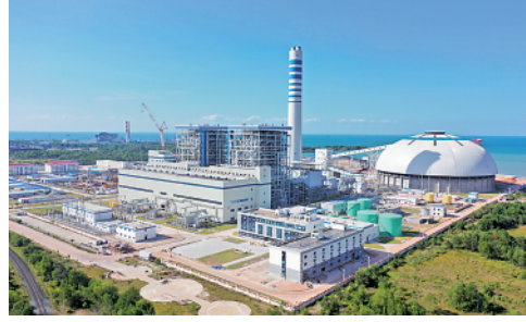
华电海外投资有限公司投资运营的柬埔寨西哈努克港燃煤电站(华电西港项目)2号机组16日正式投产发电。 新华社发(李欣琳摄)
