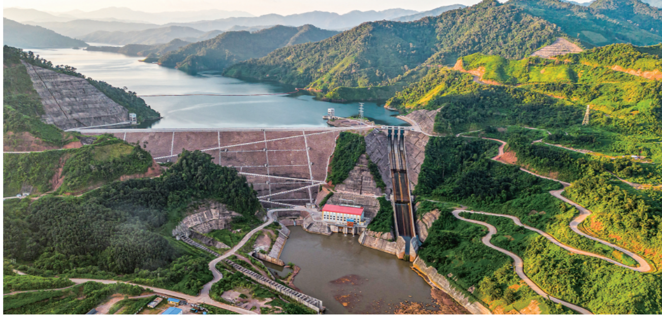
这是2022年9月27日航拍的中国电建南欧江流域梯级水电项目位于老挝北部丰沙里省的七级电站。 新华社发(乔丕摄)
