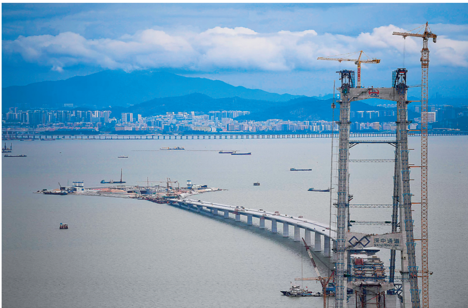
▲深中通道伶仃洋大桥东塔、西人工岛及远处的深圳市区（六月七日摄）新华社记者邓华摄
