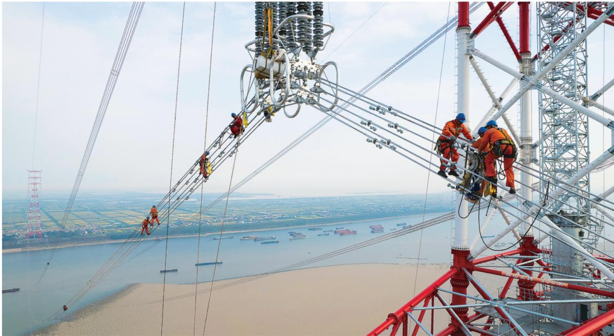
9月18日，在位于湖南省岳阳市临湘市的南荆长特高压工程螺山长江大跨塔施工现场，国网山东送变电工程有限公司的工作人员安装阻尼线。
