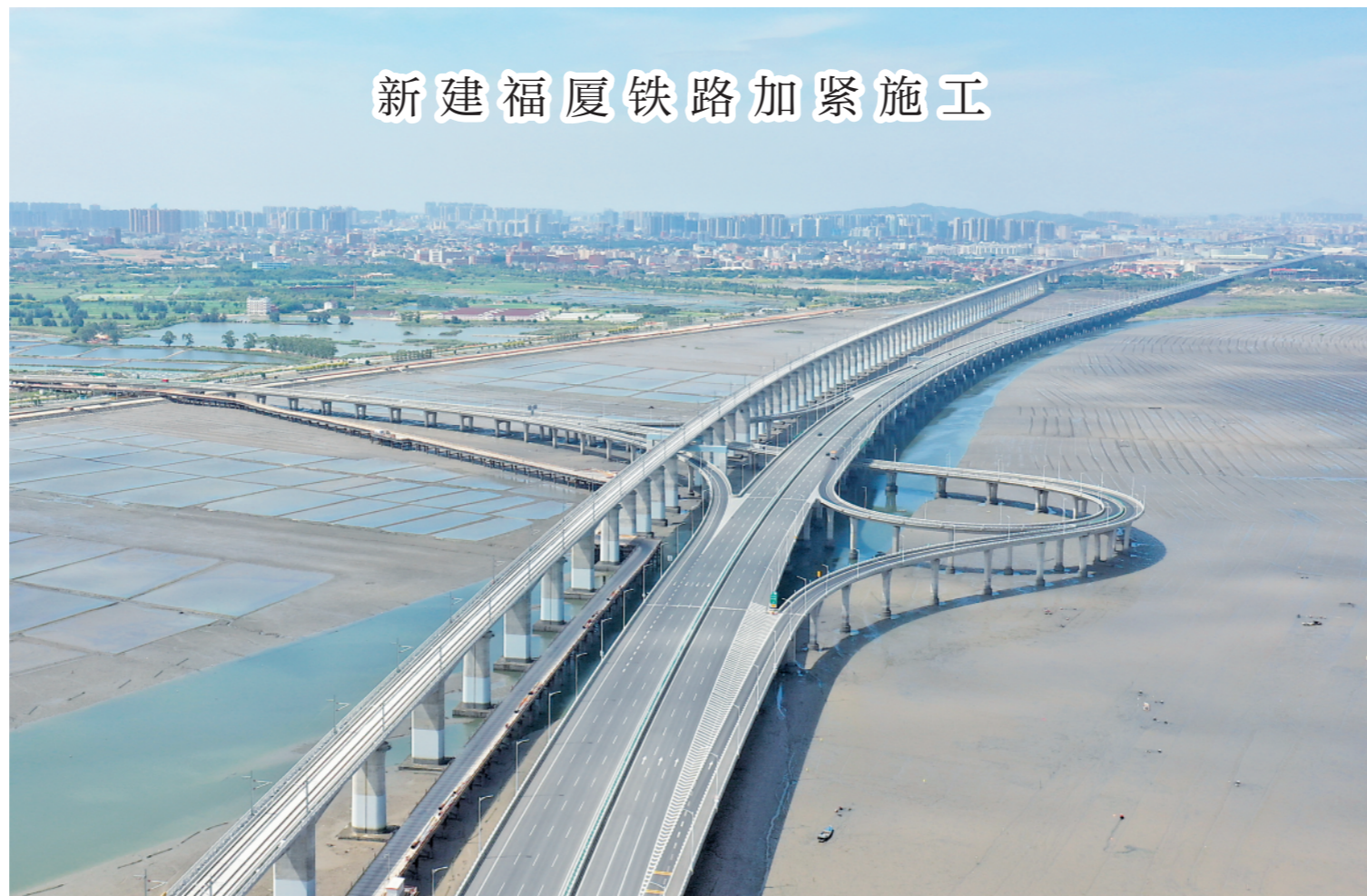
▲这是9月2日拍摄的新建福厦铁路泉州湾跨海大桥。近日,我国首条跨海高铁——新建福州(厦门)铁路铺轨施工全线贯通。目前,铁路沿线站房等工程正加紧建设。据悉,新建福厦铁路设计时速350公里,正线全长277.42公里,建有湄洲湾、泉州湾、安海湾三座跨海大桥,全线共设8座车站。铁路建成通车后,福州、厦门两地将实现“一小时生活圈”,厦门、泉州、漳州闽南“金三角”将形成半小时交通圈。 新华社记者林善传摄
