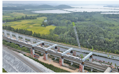
9月3日,黄黄铁路跨宁安高铁钢盖梁吊装完成,为后续工程施工提供了保障。 新华社记者刘军喜摄
