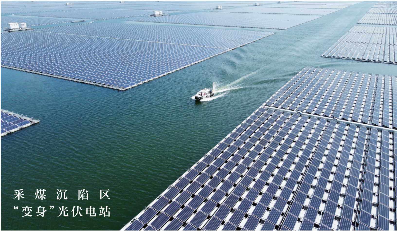
▲ 8 月 25 日拍摄的颍上县毛圩水上光伏电站。近年来,安徽省阜阳市颍上县古城镇积极推进采煤沉陷区治理工作,将昔日的采煤沉陷区建设成水上光伏电站,既减少占用土地面积,又能生产清洁能源。据了解,古城镇已建成水面光伏电站并网装机容量 130 兆瓦,年均发电量 1.36 亿千瓦时,每年可节约标准煤约 5.44 万吨,减少二氧化碳排放量约 13.56 万吨。 新华社记者黄博涵摄
