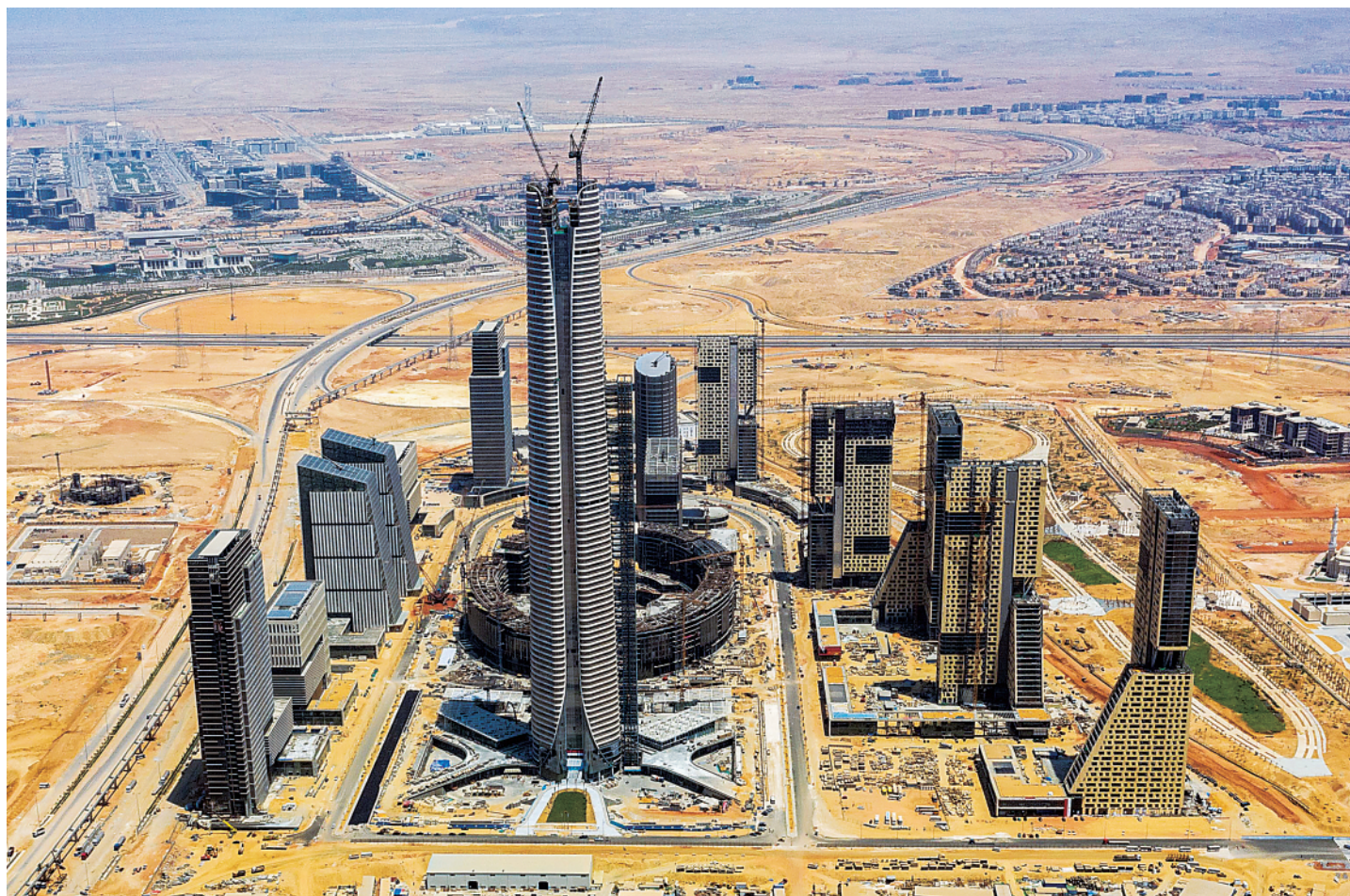
▲这是2022年7月19日拍摄的埃及新行政首都中央商务区项目(无人机照片)。新华社发(中建埃及供图)
