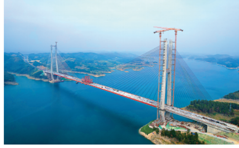
十(堰)浙(川)高速公路丹江口水库特大桥于8月20日晚顺利合龙,湖北段全线实现贯通(8月21日摄)。新华社发(谢刚摄)
