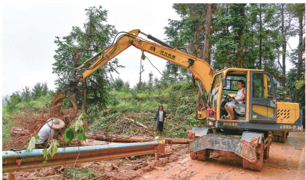
▲6月28日,工人驾驶机械清理从江县城至丙妹镇大洞村公路两旁的倒伏的树木。6月18日以来,贵州从江县多地遭遇强降雨天气,引发洪涝灾害。当地积极组织力量进行灾后抢修重建,道路交通、供水供电、通讯等也逐渐恢复正常。新华社记者杨文斌摄
