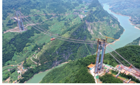
6月28日，贵州金(金沙)仁(仁怀)桐(桐梓)高速桐梓河特大桥第一节钢桁梁开始进行吊装。新华社记者刘续摄
