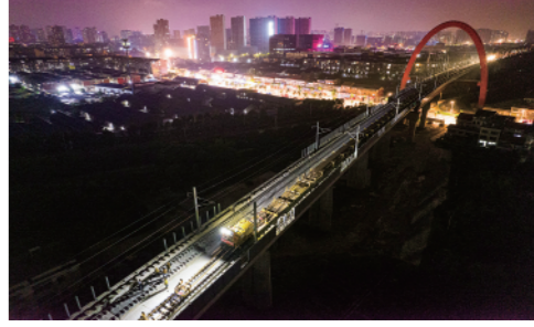
常(德)益(阳)长(沙)铁路常益段进入铺轨阶段,6月18日凌晨,一辆500米长轨运输车正在作业。新华社记者陈思汗摄
