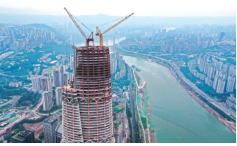
6月18日，重庆陆海国际中心项目主塔楼正式封顶，主塔楼建筑高度458.2米。新华社记者王全超摄
