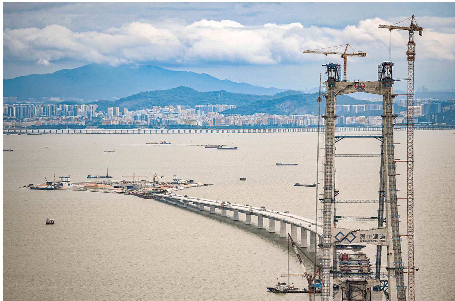
▲这是6月7日拍摄的深中通道伶仃洋大桥东塔、西人工岛及远处的深圳市区。
