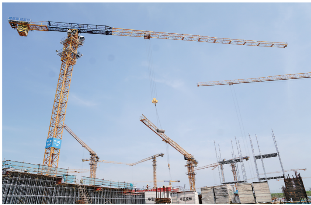
▲6月15日拍摄的位于上海市青浦区的华为青浦研发中心项目工地。当前,上海在抓好疫情防控工作的基础上,全力以赴保生产、稳运行。 新华社记者丁汀摄
