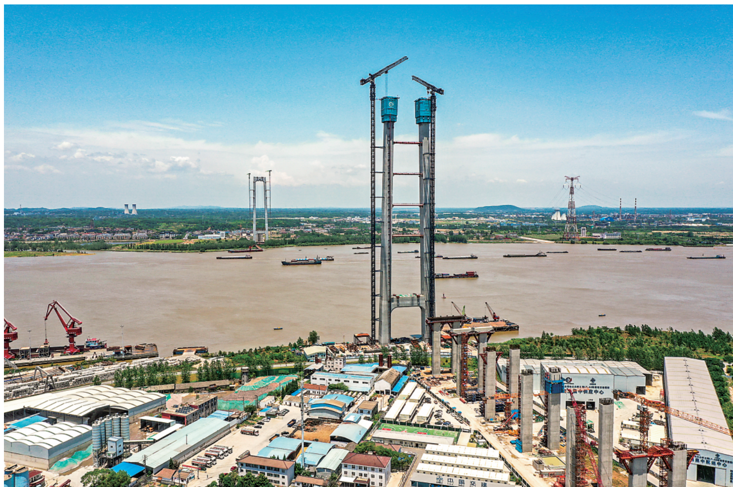
▲建设中的龙潭长江大桥(6月10日无人机照片)。
