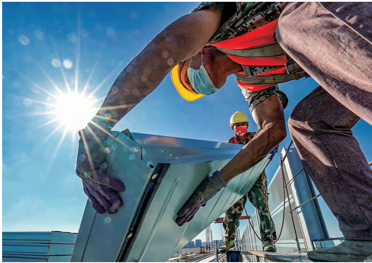
近日,国家重点工程京唐城际铁路建设正在按照节点要求扎实推进。这是六月七日,工人在唐山市高新技术开发区境内京唐城际铁路建设现场施工。新华社记者杨世尧摄
