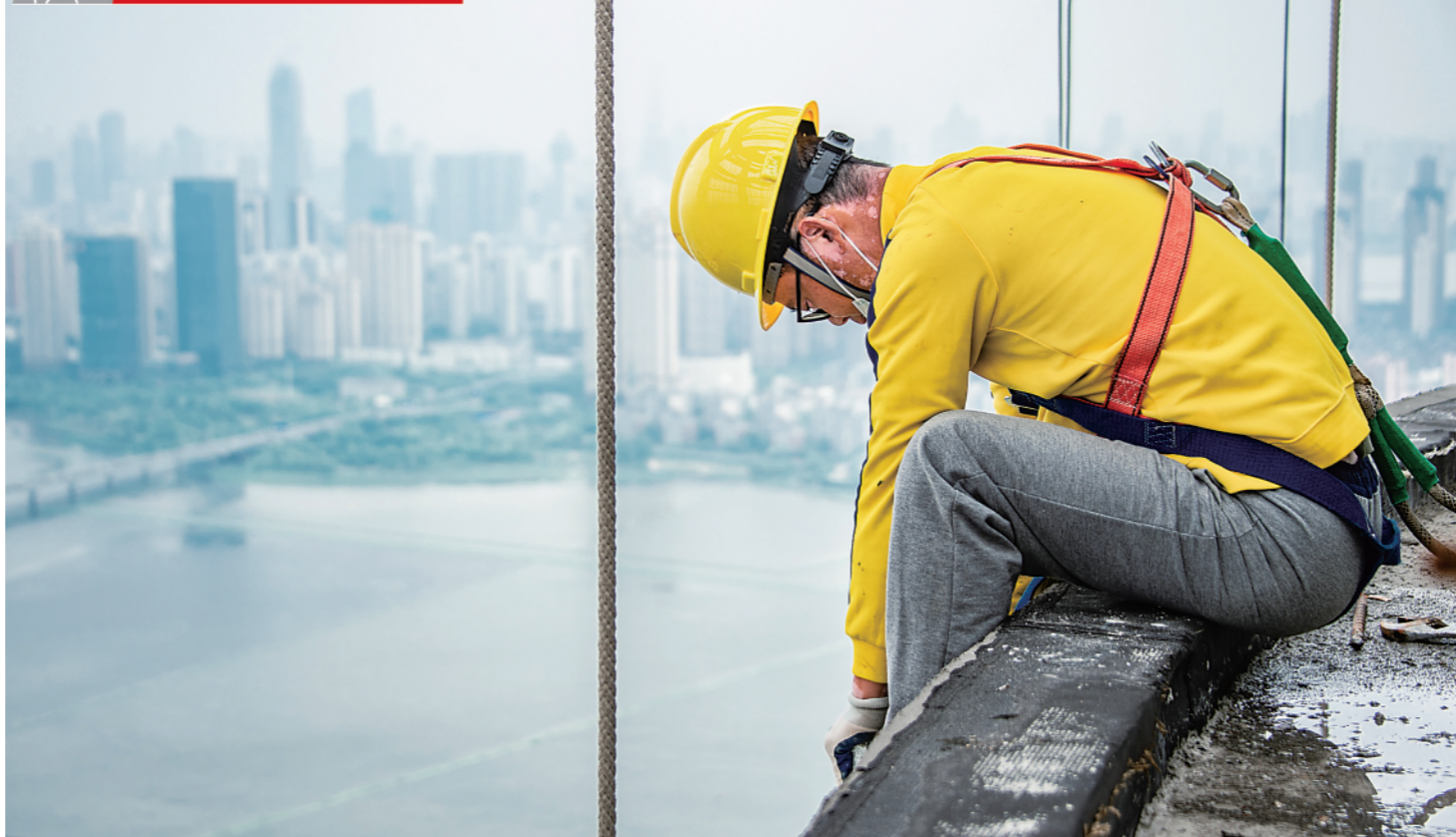
▲4月29日,武汉襄阳大厦项目工人在260多米高的大楼顶层进行高空作业。“五一”期间,在260多米高的项目大楼上,500多名工人抓紧推进工程进度,用汗水筑起城市发展梦。
