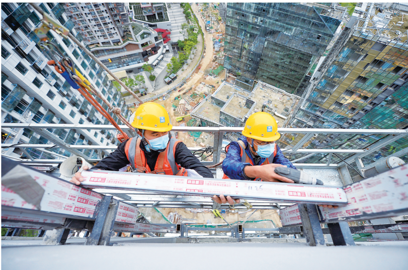
4月30日,工人在成都某工地为一栋超高层建筑安装幕墙。五二小长假期间,在成都某工地施工现场,中建五局不二幕墙装饰有限公司西南分公司的一百多名建设者坚守岗位。新华社记者刘坤摄
