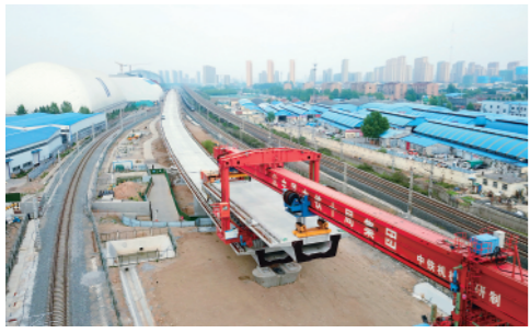
4月30日,中铁十局的建设者完成济南黄台联络线最小曲线半径双箱梁架节点工程任务。新华社记者郭绪雷摄
