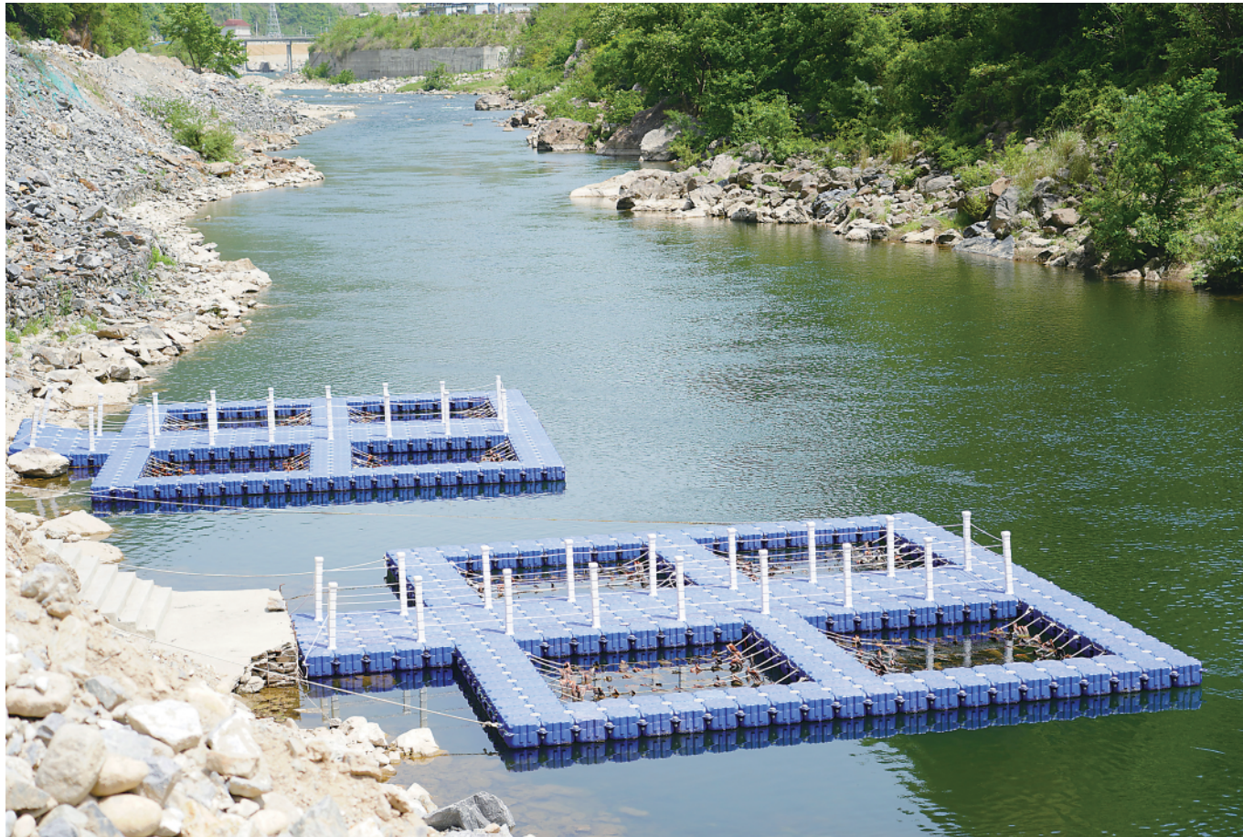
▲图为引汉济渭工程中，三河口水利枢纽配套建设的人工鱼巢，该设施用于帮助鱼类繁衍（4月19日摄）。 新华社记者邵瑞摄
