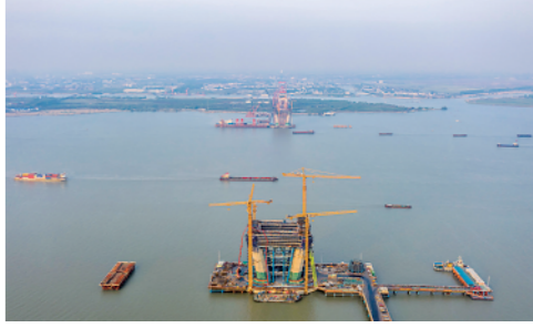
4月16日,常泰长江大桥北主塔顺利完成横梁混凝土浇筑,大桥建设取得重大进展。新华社发(汤德宏摄)
