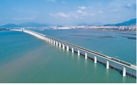
4月15日,新建福厦铁路湄洲湾跨海大桥顺利铺轨,为新建福厦铁路早日建成通车奠定基础。新华社发(周义摄)
