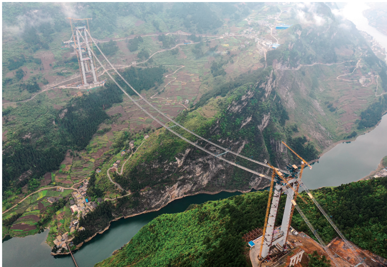
三月三十日,已架设完成首根主缆的桐梓河特大桥。由中铁广州局承建,标志着桐梓河特大桥正式进入主缆架设施工阶段。新华社记者刘续摄
