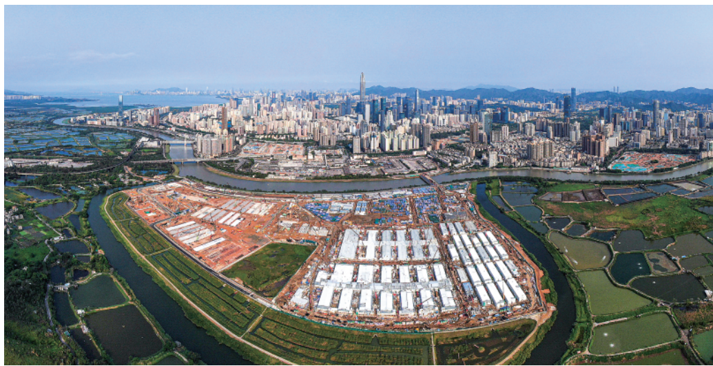
▲中央援港应急医院项目一期工程进入联调联试阶段，这是建设中的中央援港应急医院和方舱医院(3月27日摄)。 新华社记者梁旭摄
