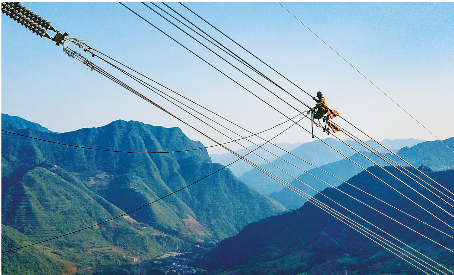
▲2020年5月3日，施工方国网四川电力送变电建设有限公司员工在秦岭之巅的高空紧线。
