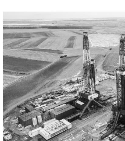
▲大庆油田1205钻井队等在一处井场施工。新华社发（李海阳摄）
