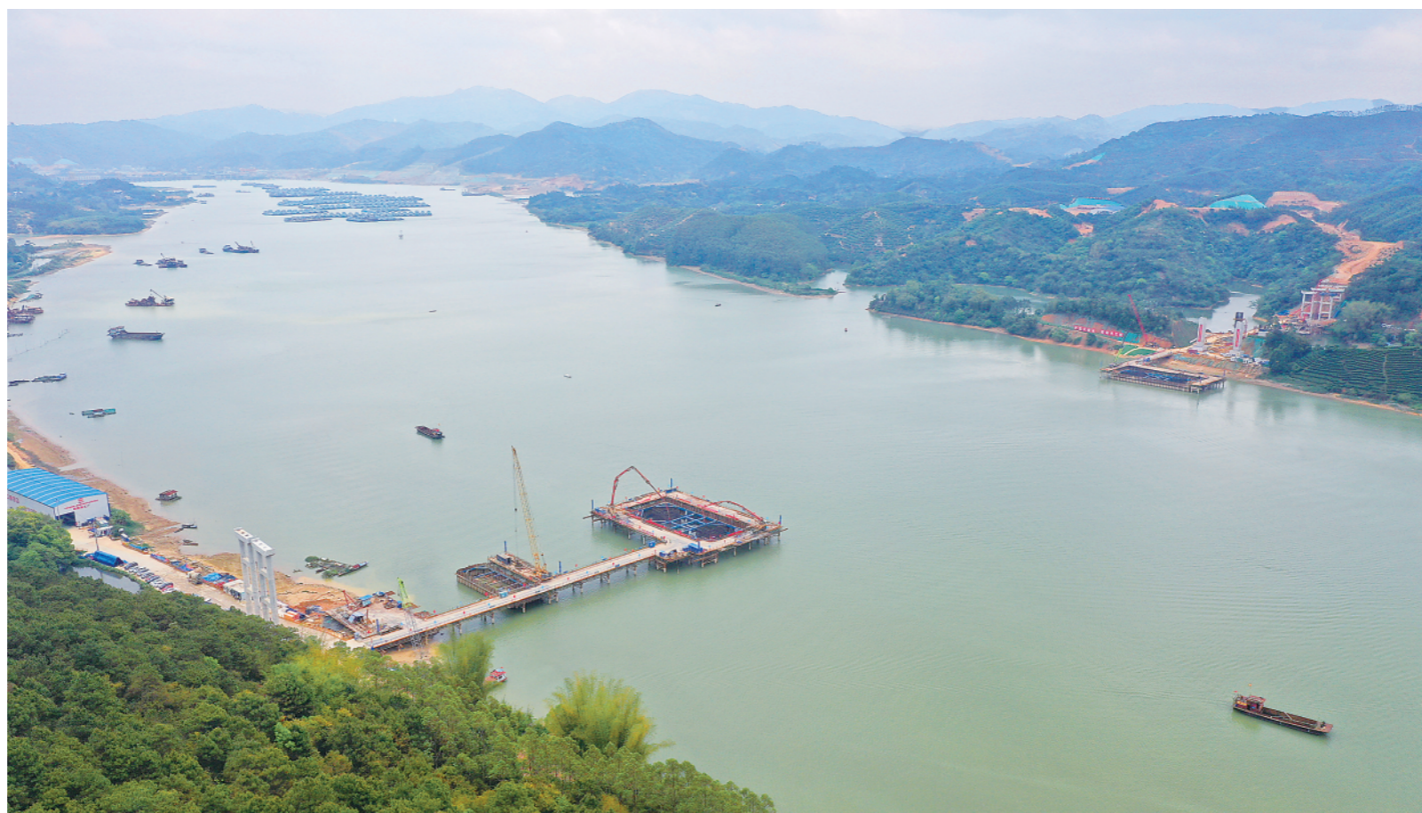
▲广西上林至横州高速公路西津郁江特大桥建设现场(3月21日摄，无人机照片)。3月21日，在广西上林至横州高速公路建设施工现场，工人们加班加点完成控制性工程——西津郁江特大桥水中承台的浇筑作业。近日广西气温回升，各地建设者加快推进高速公路项目建设，为早日实现“县县通高速”目标努力。 新华社记者陆波岸摄
