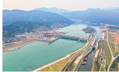
广西大藤峡水利枢纽工程为保证鱼类正常洄游和繁殖而建造的仿生态过鱼通道已投入使用(3月11日摄)。新华社记者曹伟铭摄
