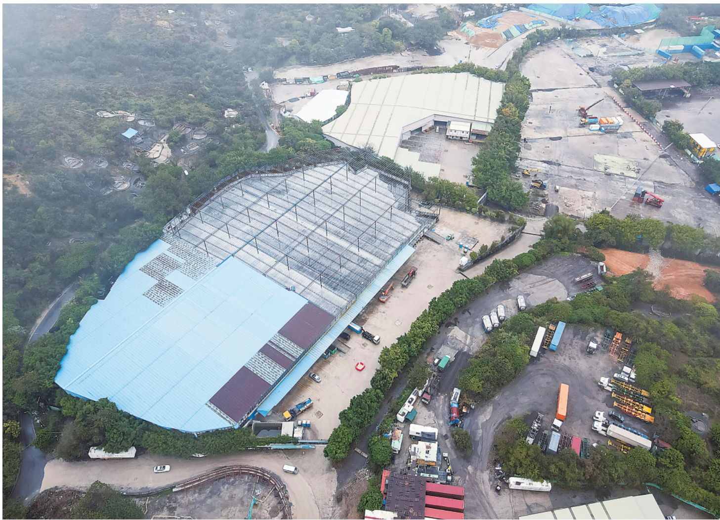
▲2月22日拍摄的香港洪水桥临时性社区隔离治疗设施建设现场。
