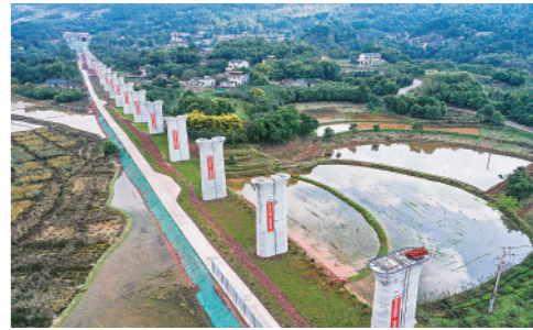
这是建设中的渝昆高铁马家屋基特大桥施工段(2月9日摄)。春节过后，渝昆高铁各参建单位加速建设。新华社记者王全超摄
