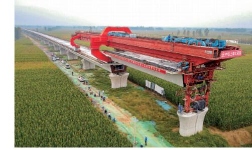
近日，国家重点建设项目郑（州）济（南）高铁山东段中铁上海局标段首架方向箱梁架设完成。
