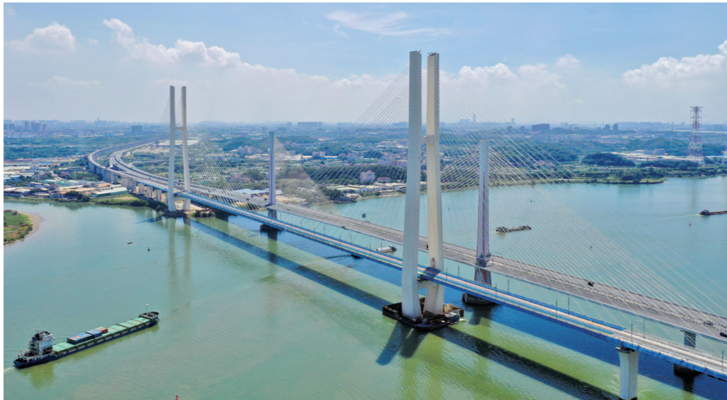
广州南沙港铁路跨西江特大斜拉桥完成左线铺轨
