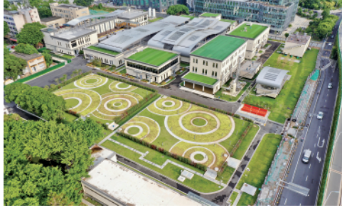
近日,福州市东南区水厂工艺改造项目顺利通过竣工验收,投入运营,日供水量15万吨(8月11日摄)。新华社记者姜克红摄
