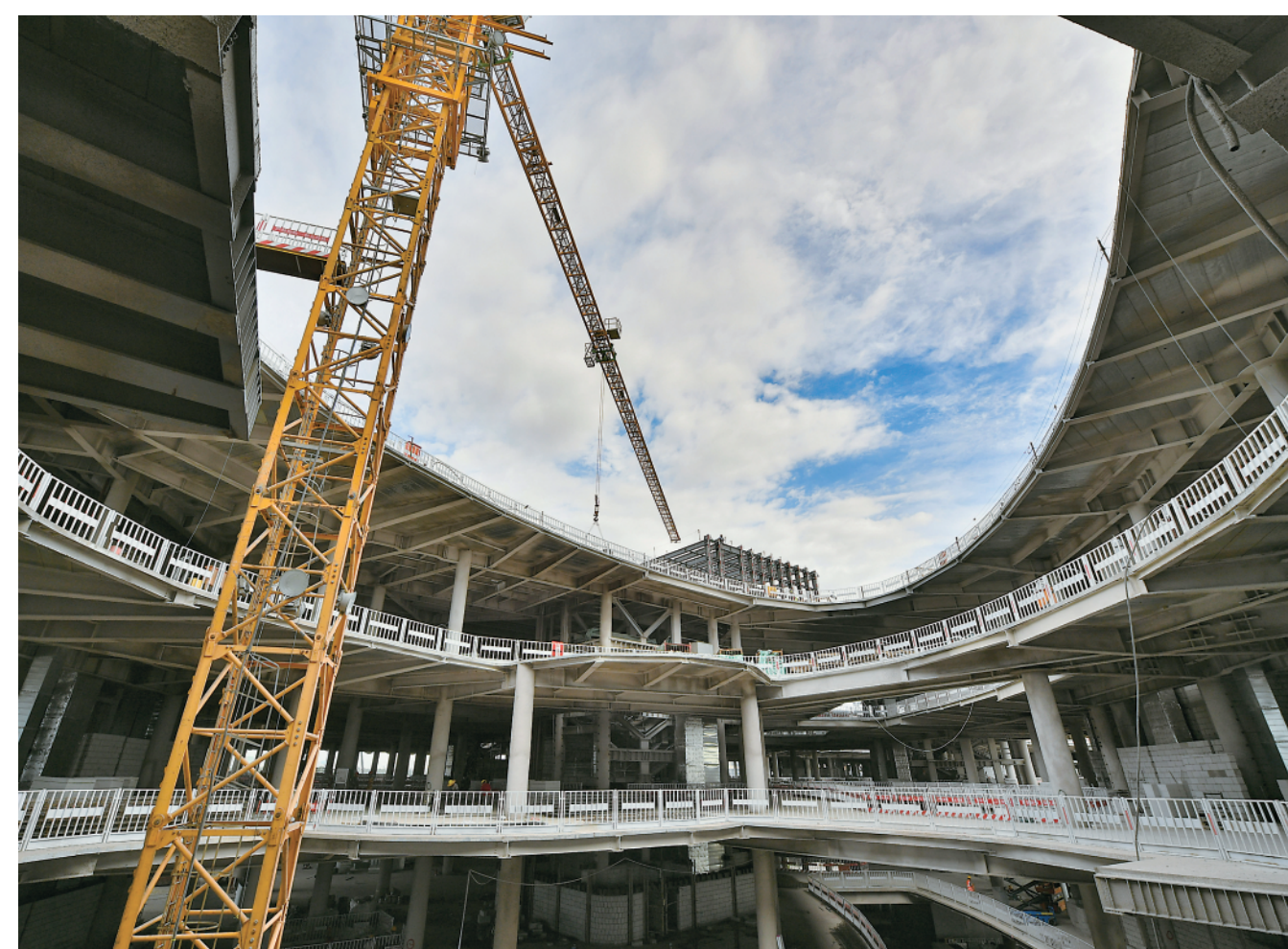
这是免税商业中心内部施工现场(7月28日摄)。 近日,海口国际免税城免税商业中心主体结构施工完毕,目前在进行玻璃幕墙及屋面网架结构样板施工。海口国际免税城项目总建筑面积约92.6万平方米,预计2022年正式营业。 新华社记者郭程摄
