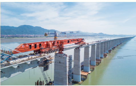
7月11日,我国自主研发的“昆仑号”千吨级运架一体机圆满完成新建福厦铁路湄洲湾跨海大桥架梁任务。新华社记者宋为伟摄
