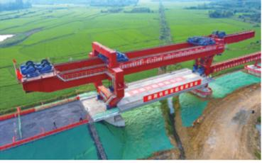
6月25日,湖北荆门至荆州铁路全线首榀箱梁架设成功。铁路建成后,将改变荆门无高铁历史。新华社记者杜华举摄
